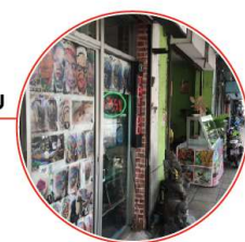
อาคารพาณิชย์กรม
