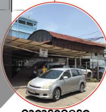
อาคารจอดรถ
